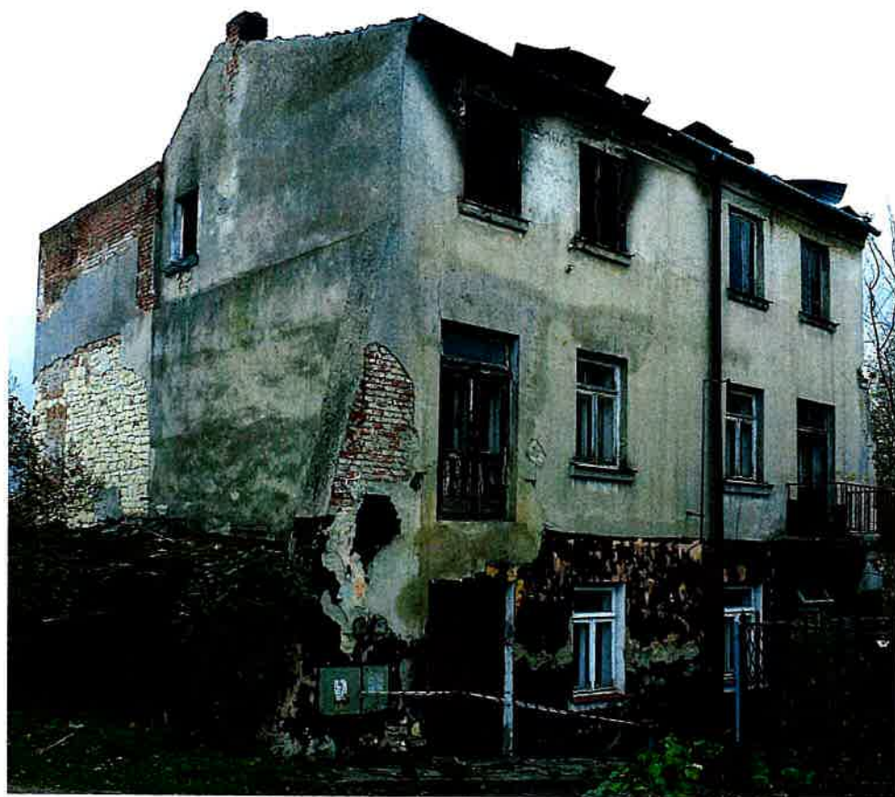
FOT.4 – ELEWACJA PÓŁNOCNO-ZACHODNIA
